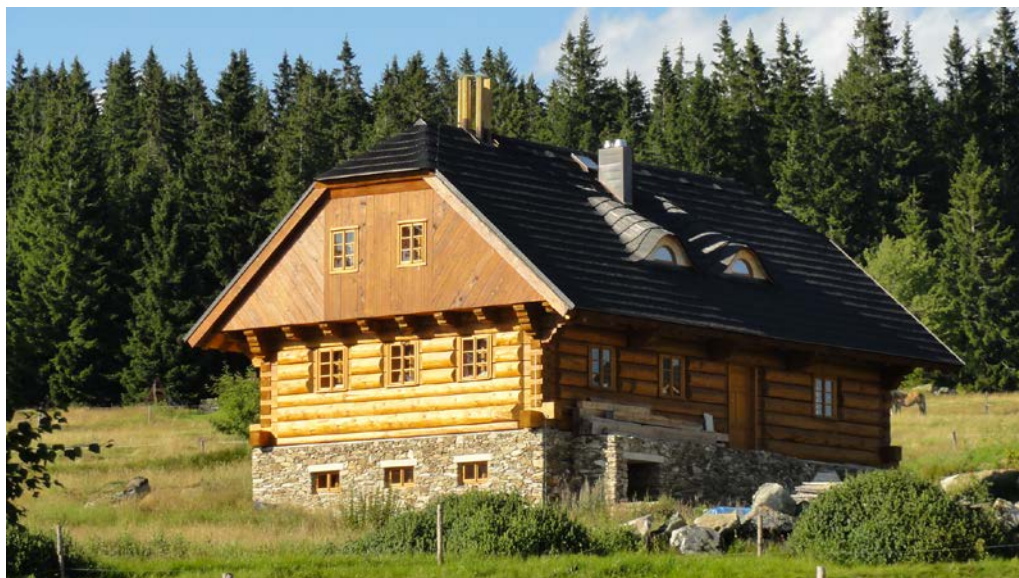
Obr. 1. Příklad použití dřevěné kulatiny v konstrukci dřevostavby-srubu
