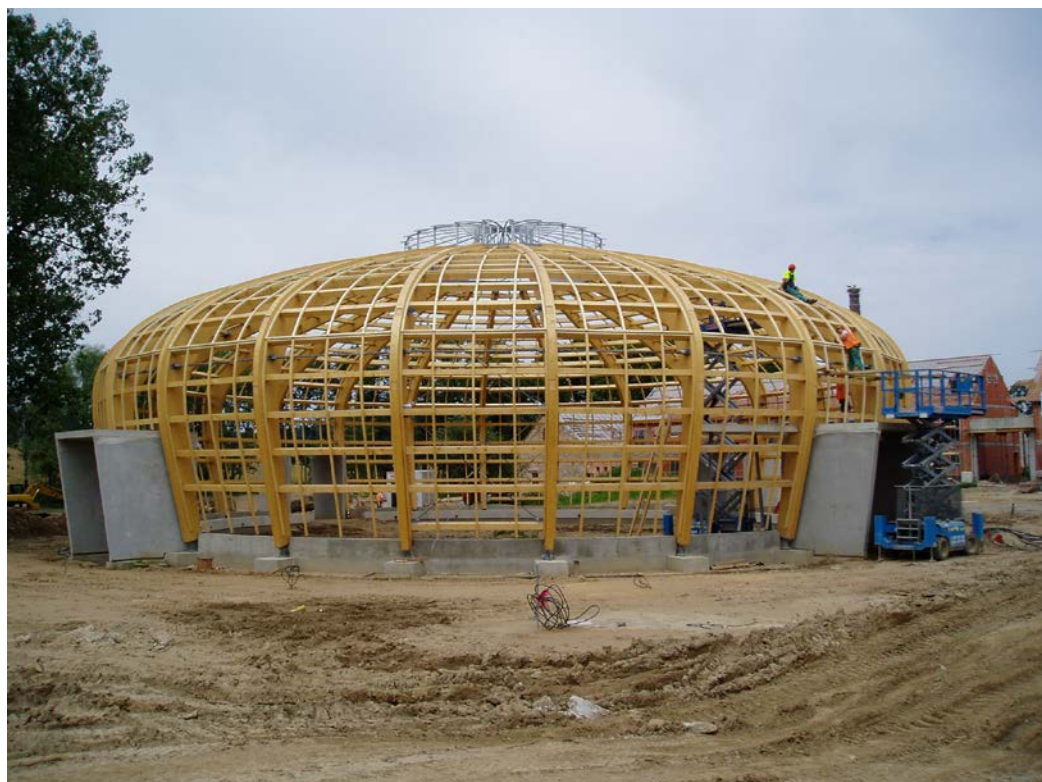
Obr. 4 Zastřešení jízdního prvku z LLD (foto: Taros Nova s.r.o.)
