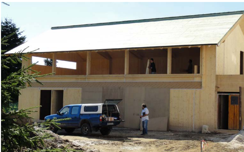
Obr. 7 Příklad dřevostavby z masivních CLT panelů
