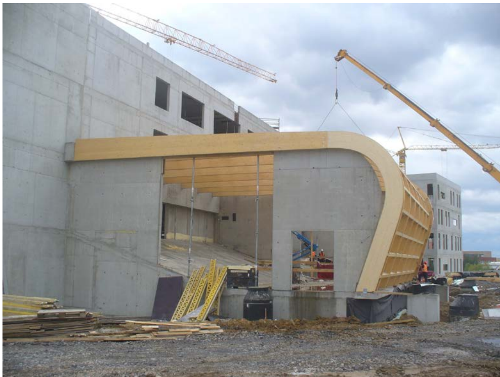
Obr. 3 Zastřešení posluchárny FEI VŠB-TUO nosníky z LLD
