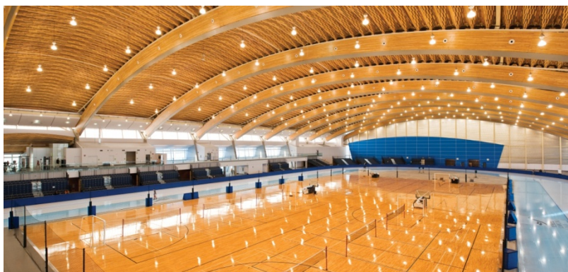
Obr. 1-2: Použití nosníků z lepeného lamelového dřeva na zastřešení stadionu v Richmondu (Kanada), zdroj http://arch-review.blogspot.cz
