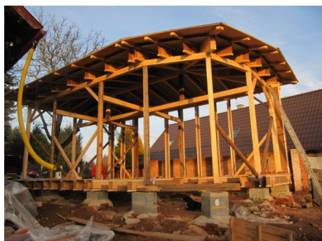
Obr. 1-3: Nosná konstrukce TDS z masivního dřeva, RD Kramolna
