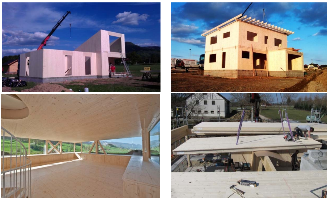
Obr. 1-23: Ukázky z realizací staveb ze systému NOVATOP v ČR, Itálii, Francii
