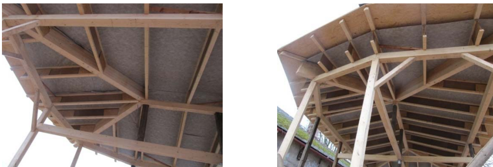
Obr.1-8 Použití dřevěných I nosníků STEICO Joist v konstrukci střechy, RD Kramolna.
