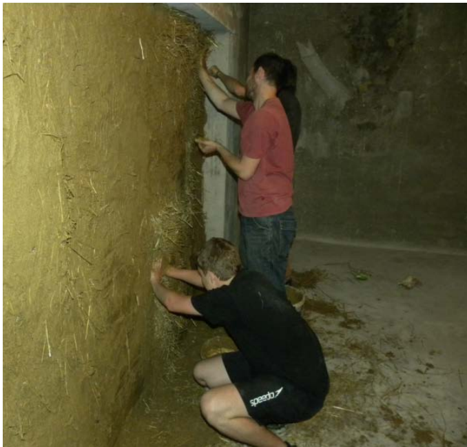
Obr. 3: Nanášení první vrstvy hliněné omítky PICAS z exteriérové strany stěny
