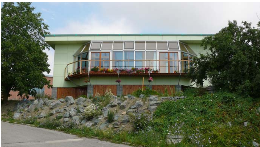
Obr. 5: Opláštění pasivního domu s dřevěnou nosnou konstrukcí – desky CETRIS Finish
