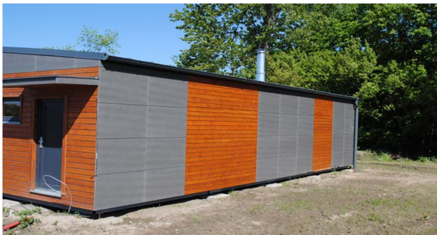
Obr. 4: Opláštění dřevostavby z desek CETRIS Lasur, kombinace s dřevěným obkladem
