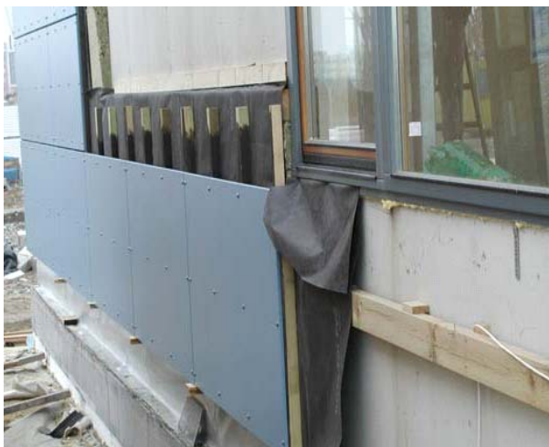
Obr. 1: Skladba fasádního systému
