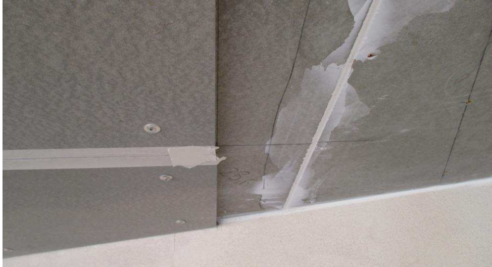
Obrázek 4.: Detail vytmelených spár cementotřískových desek
