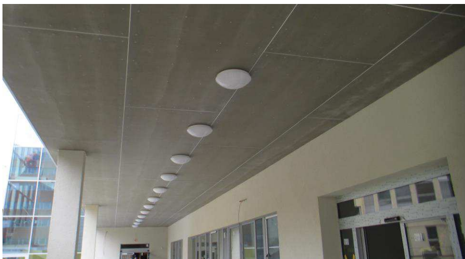
Obrázek 5.: Podhled s požární odolností po dokončení
