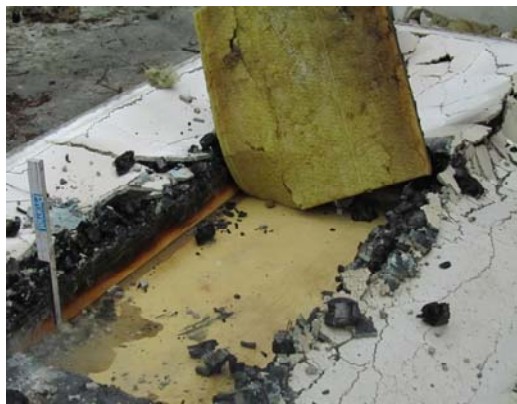
Obr. 5: Konstrukce při rozebrání
