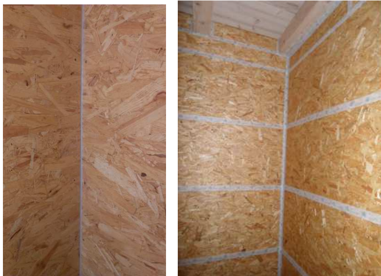
Obr. 1 Správné spojení OSB pomocí tmelů či speciálních těsnících pásek (foto: autor)
