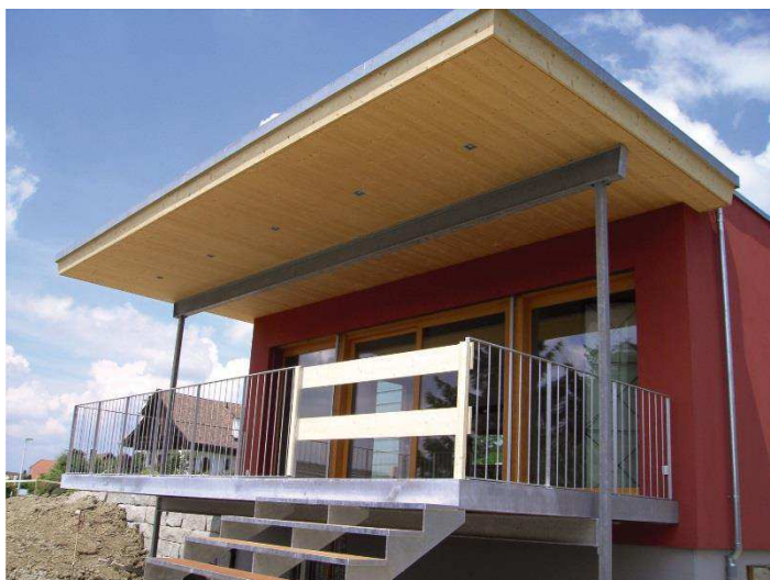
Obr. 2: Použití SWP na přesazenou střechu
