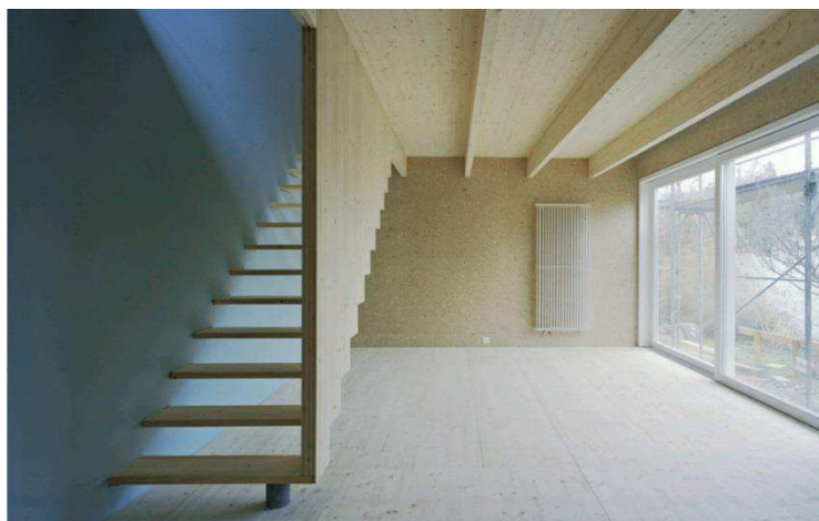
Obr. 1: Použití SWP na stropy a schody
