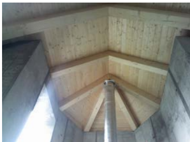
Obr.1: Konstrukce dřevěného krovu spojená se železobetonem a ocelovým sloupem
